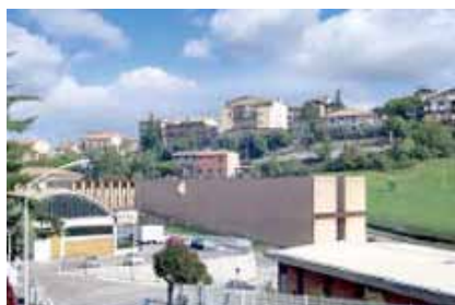
La chiesa sorge in una zona periferica della città, la facciata è attraversata da una croce costituita dalla fenditura verticale attraversata da una putrella.
