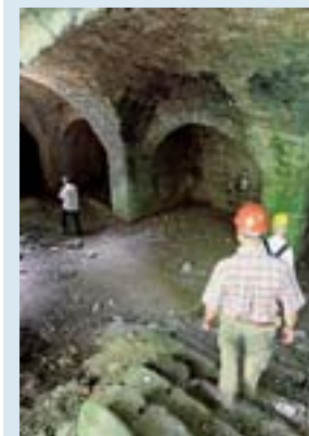
Gli operai tra i resti delle antiche mura medievali con gli innesti rinascimentali: nel '500 la ristrutturazione strategica
